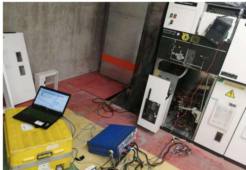
Pruebas para el **comisionamiento** y puesta en servicio de nuevos sistemas, así como para el **mantenimiento anual** y la verificación periódica de RELÉS/RTUs instalados
